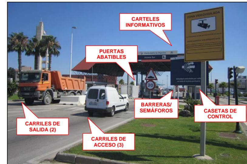
Todo el acceso cuenta con vigilancia mediante una cámara Domo para el control de toda la zona. El control de accesos está cubierto por una marquesina de estructura metálica y cubierta plana que integra todos los carriles de entrada y de salida (excepto acceso TAG).
